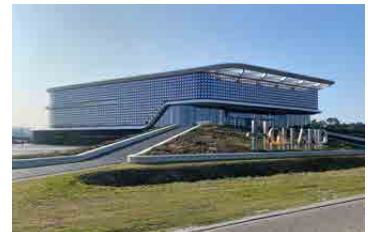
Arch. : Gensler et MSVA Architects.
