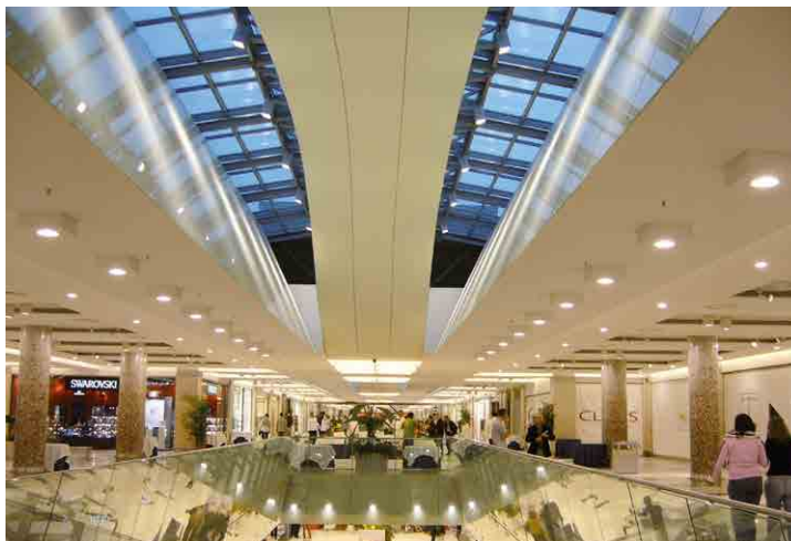
Barrisol® Star® - Arch. : Chapman Taylor Architetti
